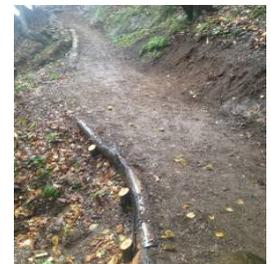
**Sentiero Contresc di sotto** – Oltre alla pulizia e alla posa di canalette e scalini lungo il sentiero, si è reso necessario l'abbattimento non previsto di alcune piante. L'aiuto di tre militi provenienti da altri cantieri ha accelerato l'avanzamento dei lavori, i quali sono stati eseguiti con maestria. Lode ai
