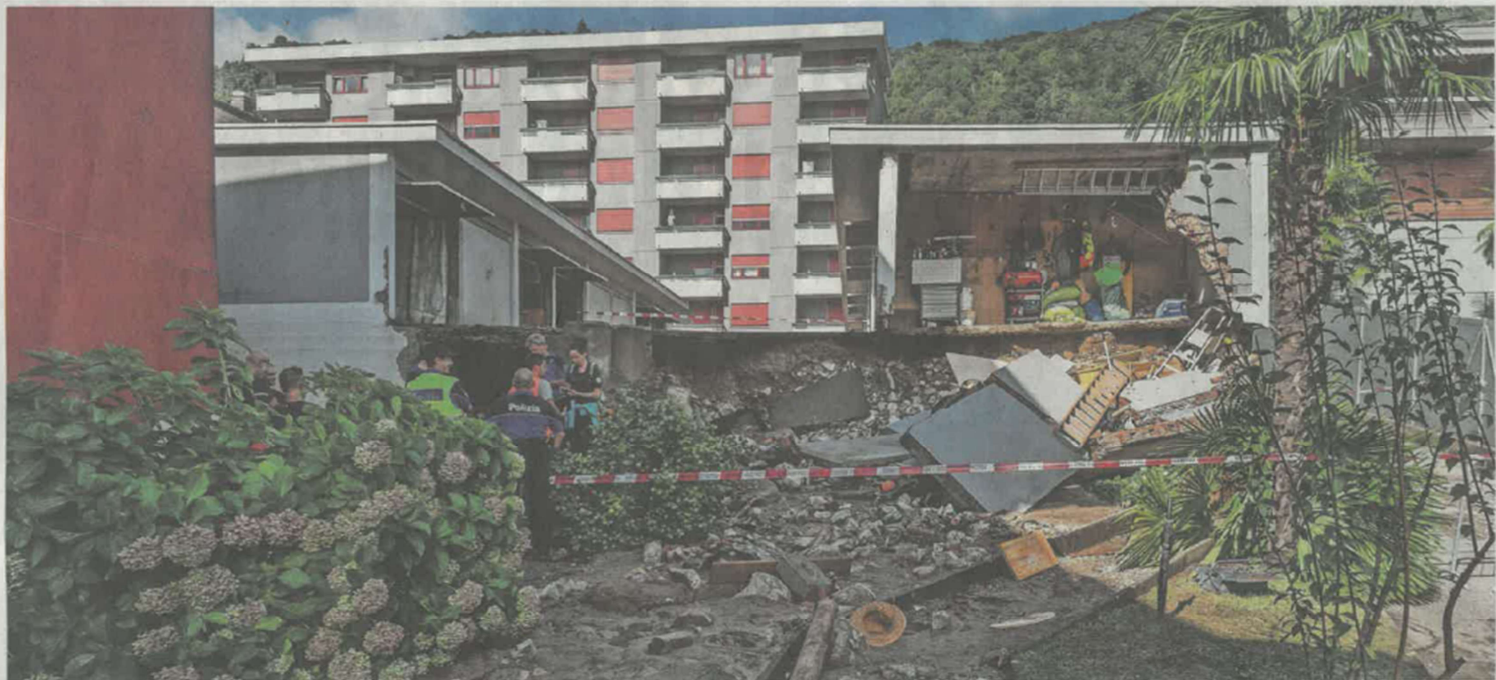
La parete di un garage crollata ad Agno.
