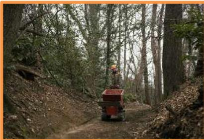
Sul cantiere di Cureglia si è provveduto alla rimozione di un ciottolato, smaltendo i detriti in benna e pulendo la strada. Il lavoro si è rivelato più complicato di quanto previsto, ma è stato
