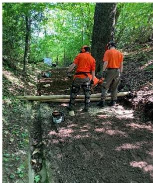
Il cantiere di Cureglia, dopo un sopralluogo e un'analisi dei possibili rischi, è stato suddiviso in 2 settori. Nel primo è stato livellato il terreno per posare 5 canalette di drenaggio in cemento, lavoro concluso con la pulizia del sentiero. Nel secondo settore sono pure state posate 4 canalette e in seguito livellato il terreno.
