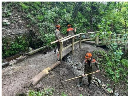
per la costruzione di due passerelle- Successivamente sono stati posati gli assi e infine è stata livellata e ripulita la zona di lavoro.
